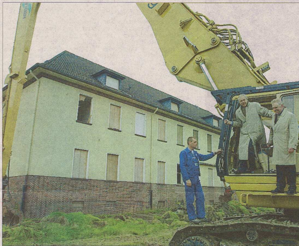
Abbruch-Kommando: Oberbürgermeister Thölke, Investor Hohnholt (v.r.)
