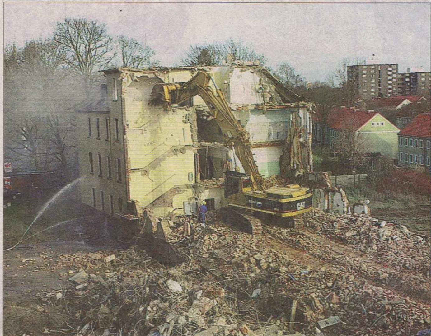
Abrissbagger zerlegen eine Kaserne; der Staub wird mit einem Wasserstrahl bekämpft. Foto: Schilling
