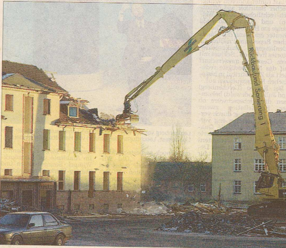
Stein für Stein wird das Caspari-Gelände derzeit dem Erdboden gleich gemacht. Im Frühjahr wollen die Investoren die ersten Wohnhäuser bauen.
