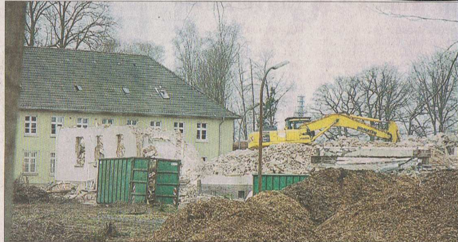
Von der Brauenkamper Straße aus gut zu sehen: Das ehemalige Offizierskasino wird abgerissen. Das Gebäude der Standortverwaltung wird folgen.
